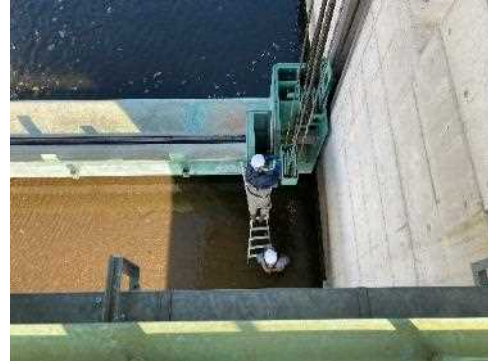
写真：頭首工ワイヤーロープ補修（取替）
