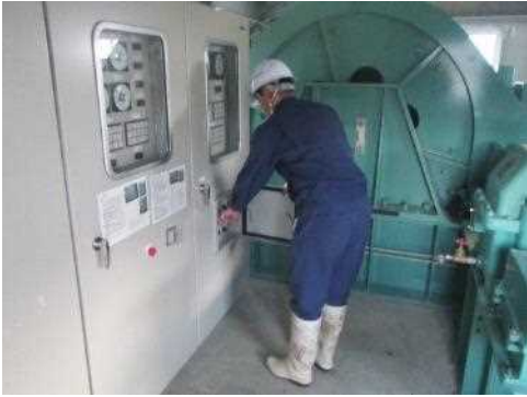
写真：頭首工内設備の点検作業
