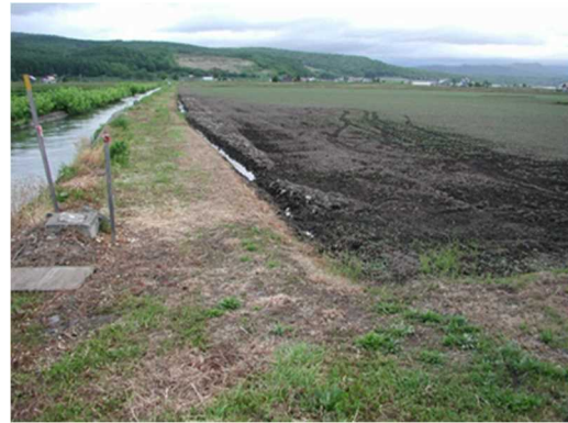
写真：比布第2支線用水路からの漏水 によりほ場が過湿の状況 （大雪土地改良区からの提供）
