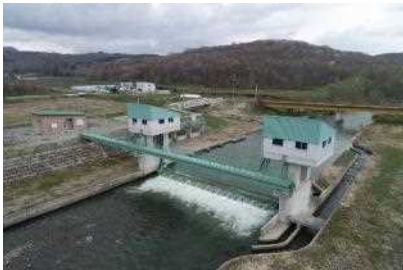
写真：頭首工整備後 (大雪土地改良区からの提供)
