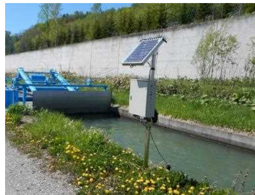
写真：水位観測機器 (大雪土地改良区からの提供)
