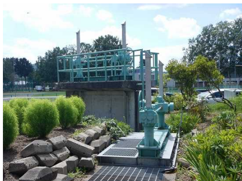
写真：石狩川導水路（令和2年5月撮影）
