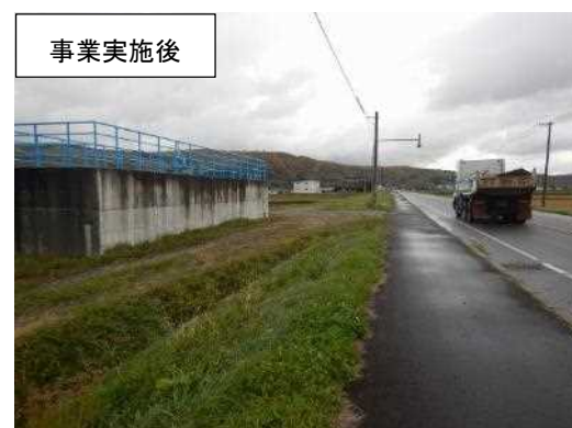
写真：比布第1号支線用水路(暗渠) (令和2年10月撮影)
