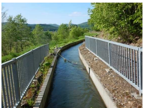
写真：共栄幹線用水路（令和2年5月撮影）
