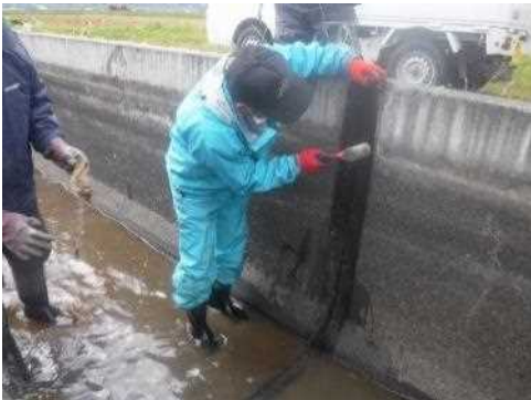
写真：比布第2号支線用水路 の目地補修作業
