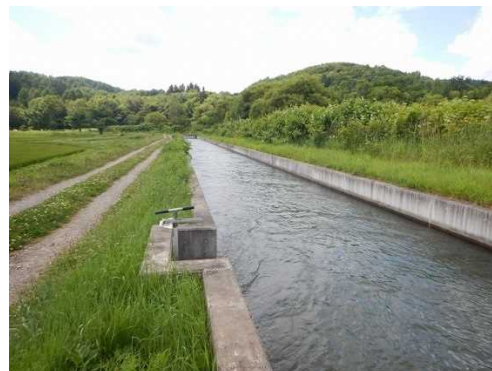
写真：比布幹線用水路（令和2年7月撮影）
