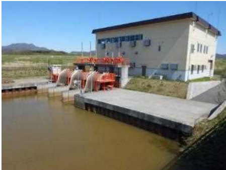
写真：誉平排水機（令和2年5月撮影）
