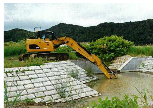
写真：誉富幹線排水路土砂除去作業
