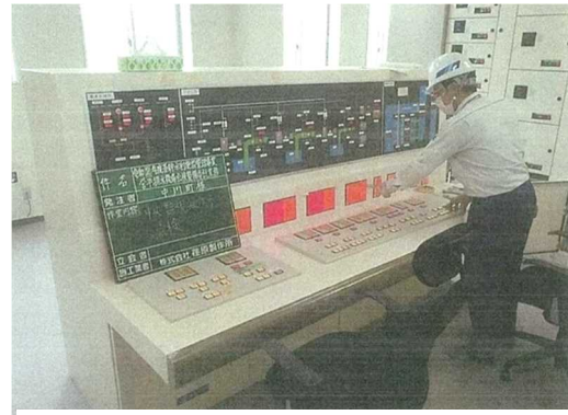
写真：監視操作制御設備の点検
