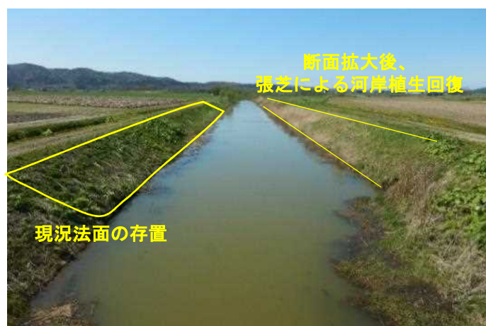
写真：誉平幹線排水路 (令和2年5月撮影)
