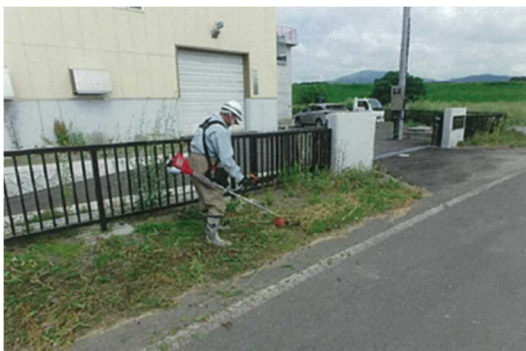
写真：排水機場周辺の草刈り作業
