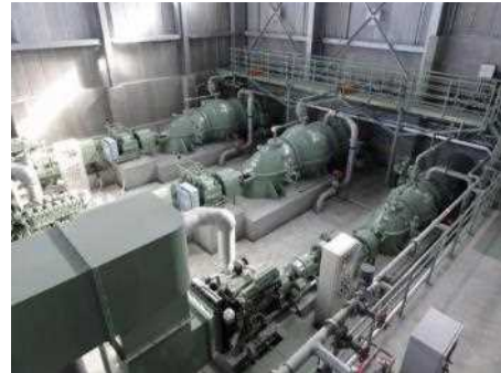
写真：排水機内部（令和2年11月撮影）
