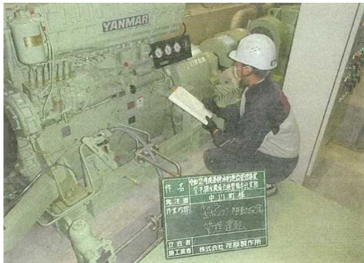
写真：主原動機の点検
