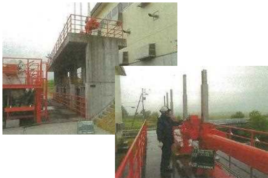
写真：樋門設備：取付水路ゲートの点検
