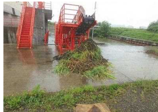
写真：排水機除塵作業
