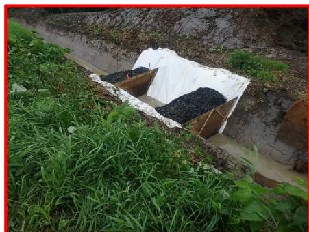
濁水処理施設の設置状況 (R元年6月撮影)
