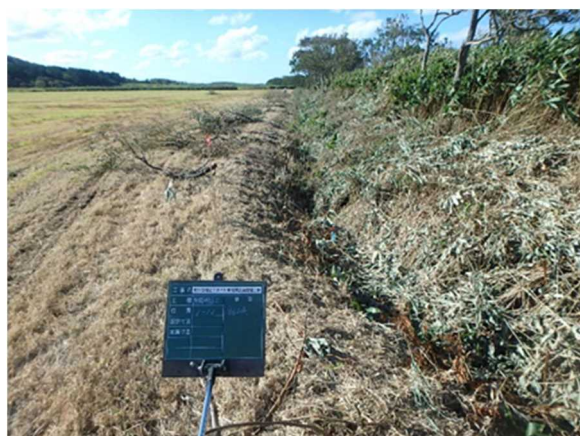
施工前の状況 (H29年9月撮影)
