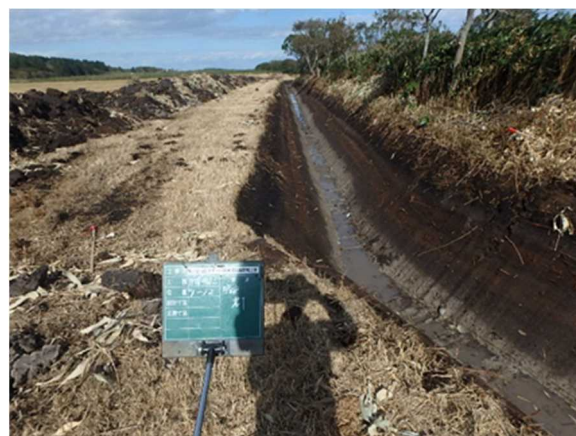
施工後の状況(隣接する河畔林を存置) (H29年9月撮影)
