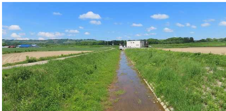
写真：勇足排水機と勇足第1排水路
