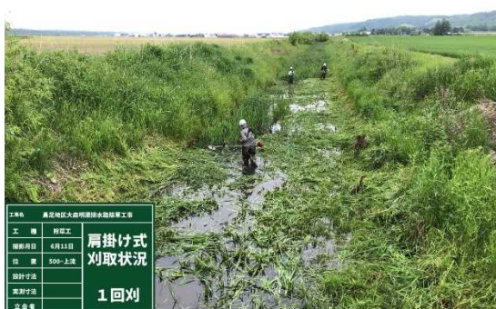
写真：排水路草刈り (本別町からの提供)
