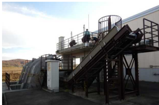
写真：操作設備点検 (令和4年11月撮影)
