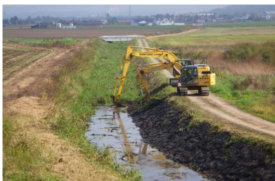
写真：排水路土砂上げ (本別町からの提供)
