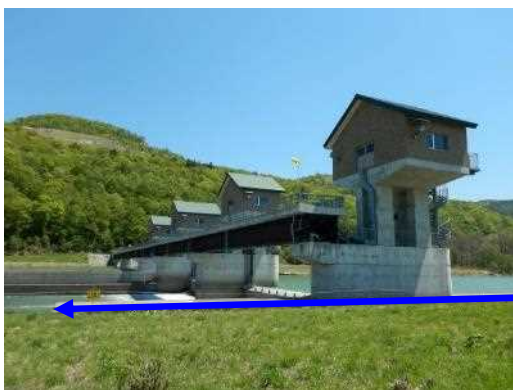
写真：空知川頭首工に設置された魚道 (令和4年5月撮影)
