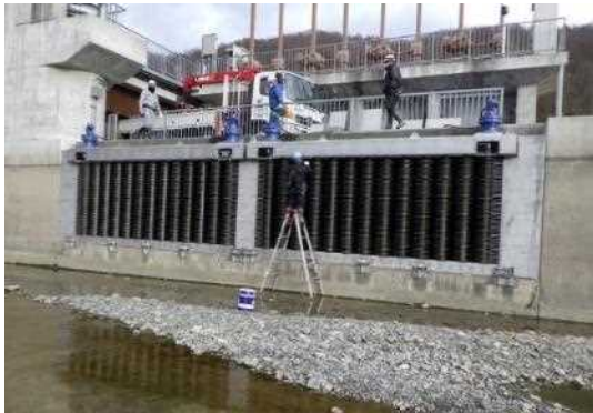
写真：除塵機点検 (富良野土地改良区からの提供)
