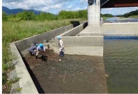
写真：魚道清掃 (富良野土地改良区からの提供)
