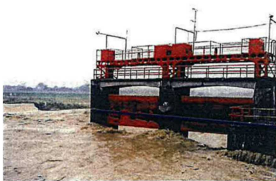
写真：平成13年9月11日洪水時状況 （頭首工上流側） （出展：旭川開発建設部より提供）
