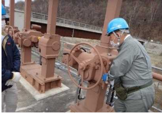
写真：ゲート点検 (富良野土地改良区からの提供)
