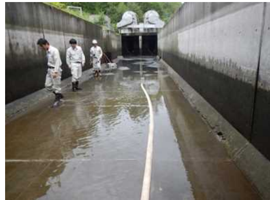
写真：清泉頭首工沈砂池水路点検 (平成 27 年 9 月 9 日撮影)
