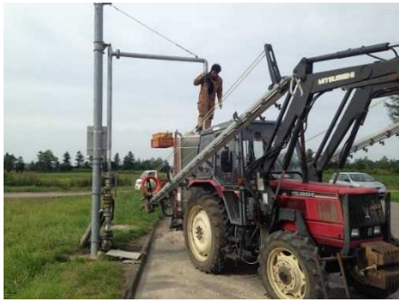
写真：給水作業 (平成 27 年 9 月 9 日撮影)
