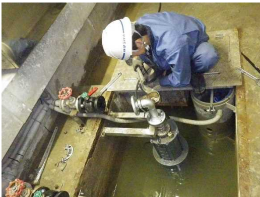
写真：緑ダム水中ポンプ取替 (平成 26 年 6 月 24 日撮影)
