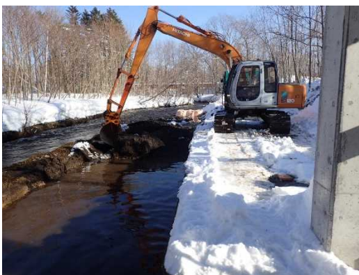
写真：札弦頭首工土砂上げ (平成 27 年 2 月 15 日撮影)
