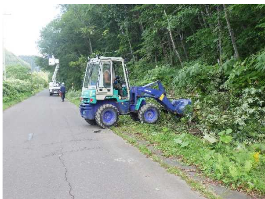
写真：管理用道路沿いの伐採作業 (平成 27 年 9 月 8 日撮影)
