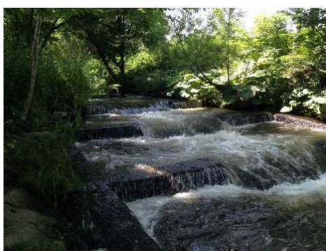
写真：階段式落差工（浦士別川） （平成 28 年 8 月 4 日撮影）
