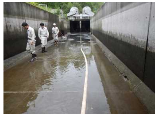
写真：写真：清泉頭首工沈砂池水路点検 (平成 27 年 9 月 9 日撮影)
