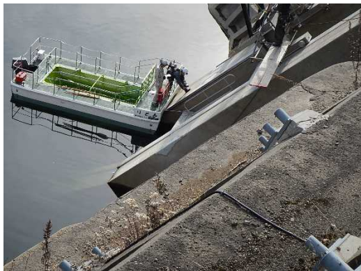
写真：緑ダム取水施設の点検・補修 (平成 27 年 11 月 5 日撮影)
