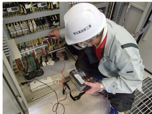
写真：緑ダム放流操作設備点検 (平成 26 年 6 月 24 日撮影)
