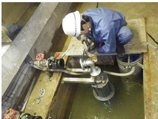
写真：緑ダム水中ポンプ取替 (平成 26 年 6 月 24 日撮影)
