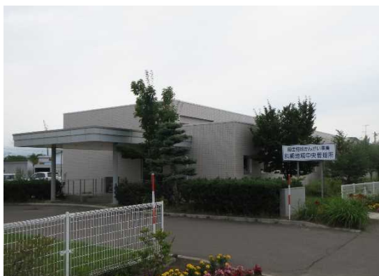
写真：中央設管理所 (平成 28 年 7 月 27 日撮影)
