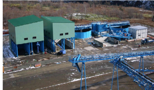
骨材製造プラント濁水処理設備 (H22 年撮影)
