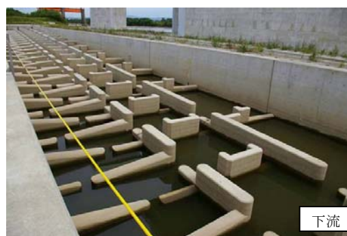
右岸魚道 (3 種類の形式組み合わせ) (H20 撮影)
