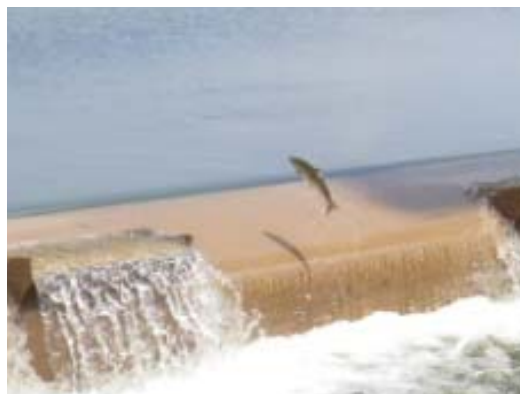
閘門式魚道を遡上するサクラマス (H27 撮影)
