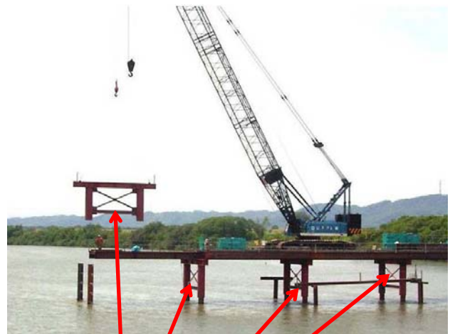
ジャケット式工法の施工状況
