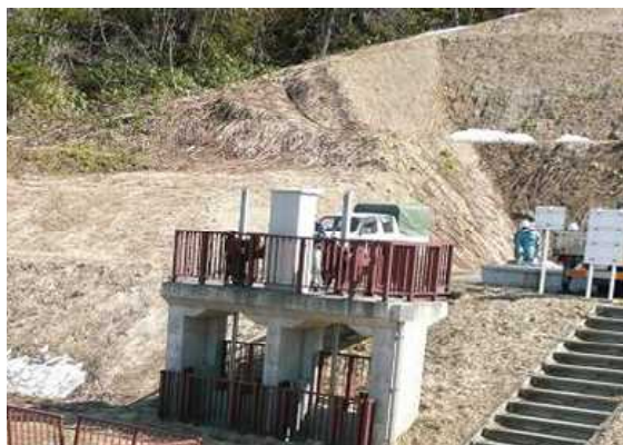
写真：通水前の頭首工点検 (平成 22 年 4 月 26 日撮影)
