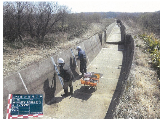
写真：用水路の目地補修作業 (平成 27 年 4 月 25 日撮影)
