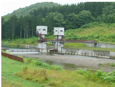
写真：中里頭首工 （平成 25 年 7 月 24 日撮影）
