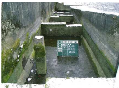
写真：住吉頭首工の魚道
