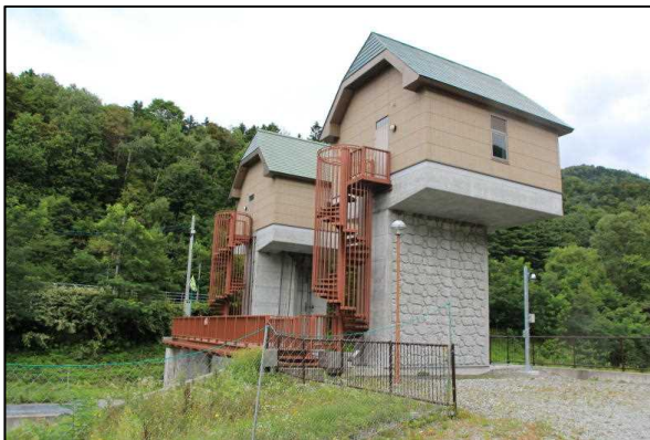
写真 : 布部川頭首工
