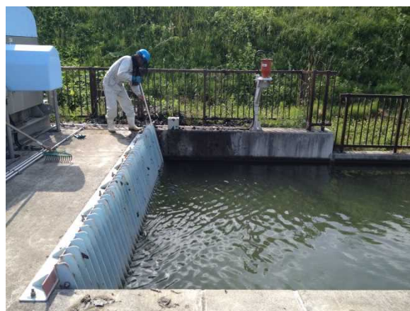
写真：除塵機のゴミ等の撤去状況 (富良野土地改良区提供)
