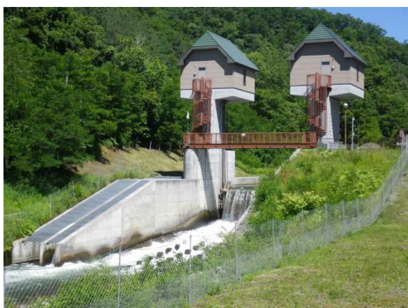
写真：布部川頭首工 (平成 27 年 7 月 8 日撮影)
