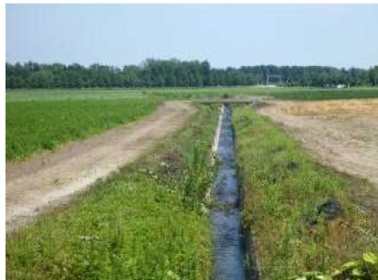
写真：草刈り後の上札内排水路 (平成27年8月5日撮影)
