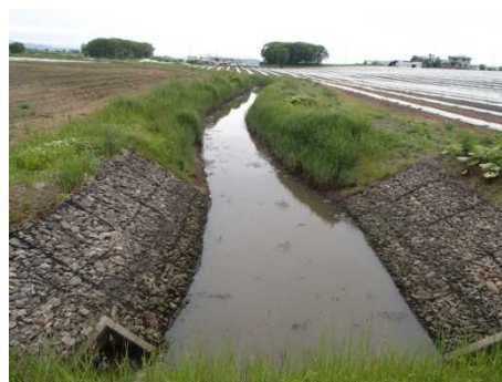
写真：第 3 号排水路 (平成 27 年 6 月 25 日撮影)
