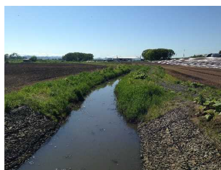
写真：第3号排水路 （平成27年6月12日撮影）
