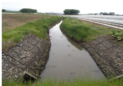
写真：第 3 号排水路
