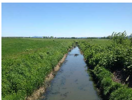
写真：第4号排水路 （平成27年6月12日撮影）
