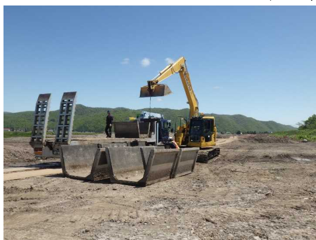
既設フルームの撤去
