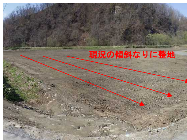
普通畑での傾斜のついたほ場状況 (H30年5月撮影)
