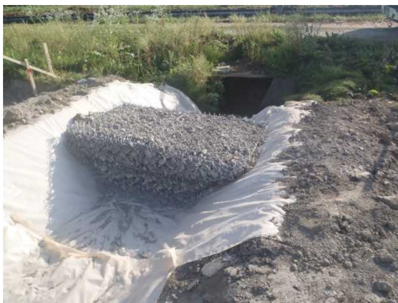
汚濁防止施設の設置状況（H29年8月撮影）
