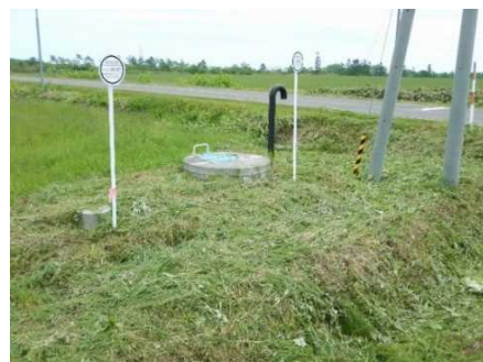
北雄武第3配水幹線の草刈り後
