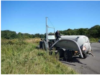
写真：給水作業（多目的給水栓） （平成 27 年 9 月撮影）
