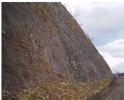
写真：ダム周辺の法面
