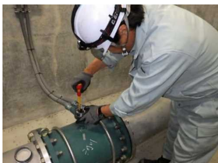
雄武ダム（河川放流管ゲート定期点検）
