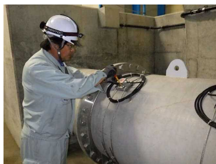
雄武ダム（導水管定期点検）
