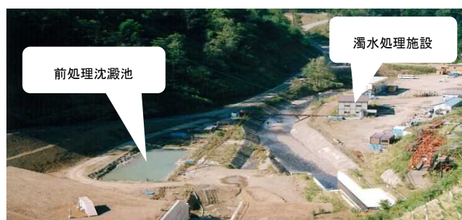
写真：ダム建設中の堤体下流部
