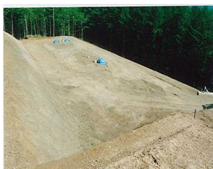
写真：ファームポンド周辺の法面
