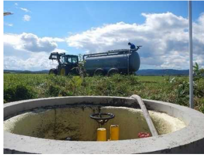
写真：給水作業（分水栓） （平成 27 年 8 月撮影）
