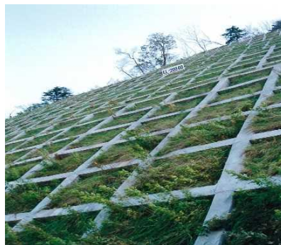
写真：ダム周辺の法面
