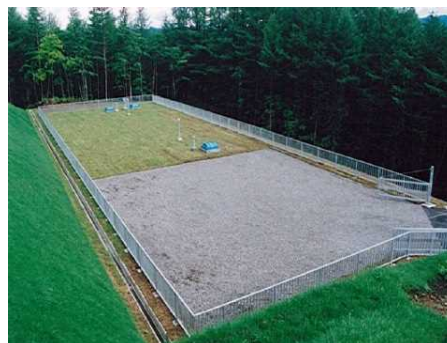
写真：ファームポンド周辺の法面
