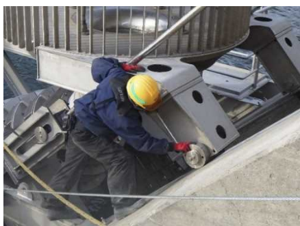
雄武ダム（シリンダーゲート定期点検）
