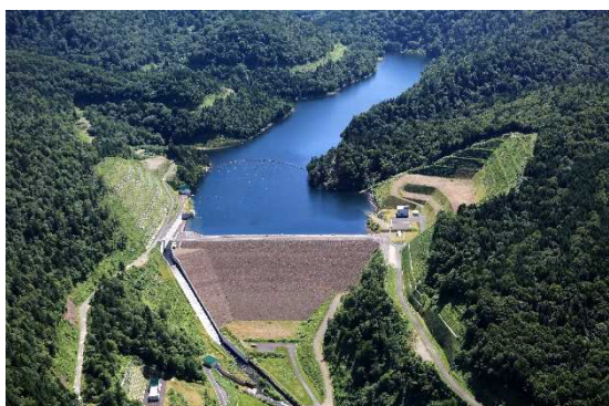
写真：雄武ダム
