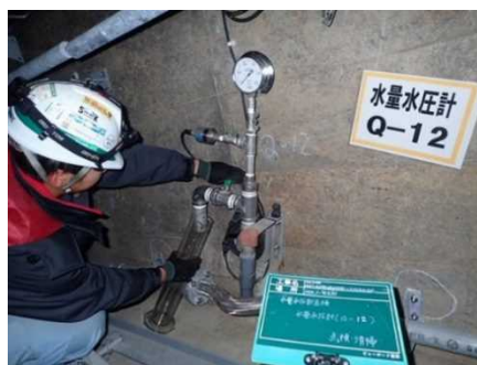
雄武ダム（堤体挙動系定期点検）
