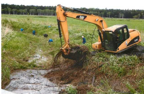
写真：排水路の土砂除去 (平成 29 年 6 月撮影)
