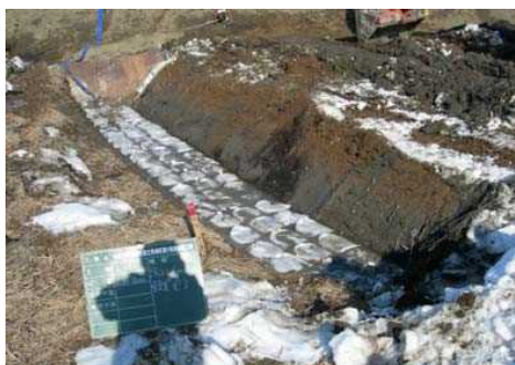
図：流入部に石灰石を布設した排水路
