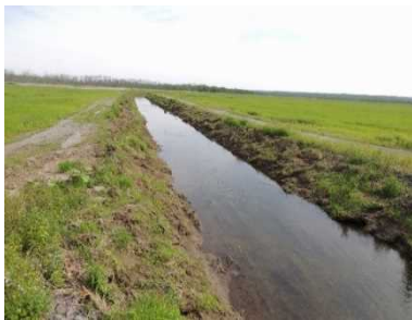
写真：雪裡1号排水路
