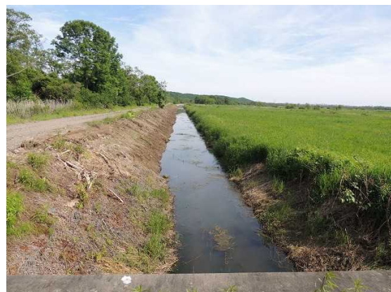
写真：雪裡2号排水路 (令和元年6月撮影)
