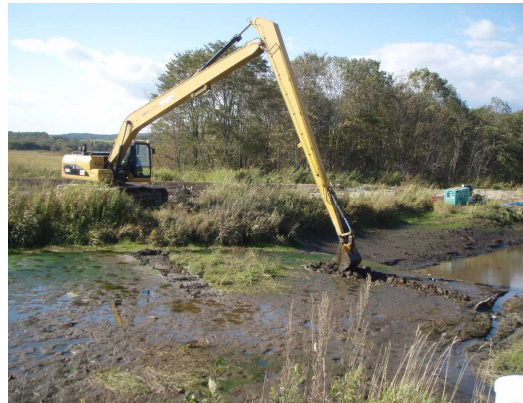
写真：雪裡2号排水路下流部に設置した沈砂池での土砂除去作業
