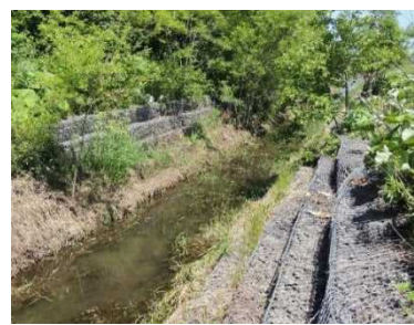
写真：幌呂1号排水路
