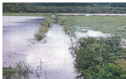
写真：排水路の溢水による湛水被害状況
