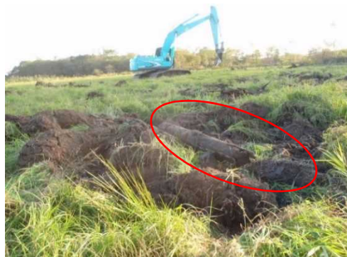
写真 : 機械の作業能率低下要因の一つである埋木を除去
