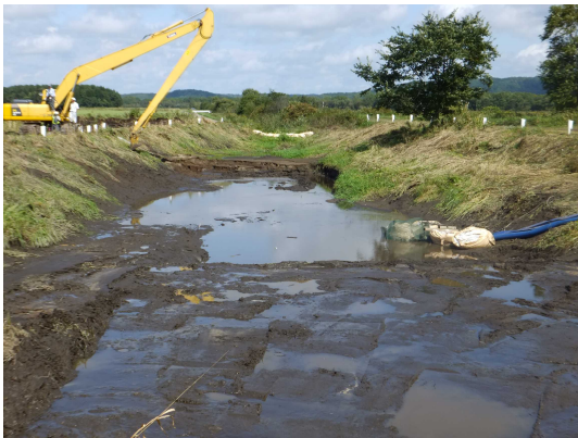
写真：幌呂1号排水路下流部に設置した沈砂池での土砂除去作業
