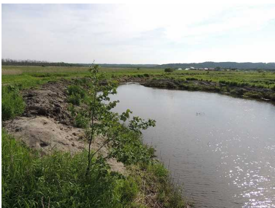
写真：幌呂1号排水路 (令和元年6月撮影)
