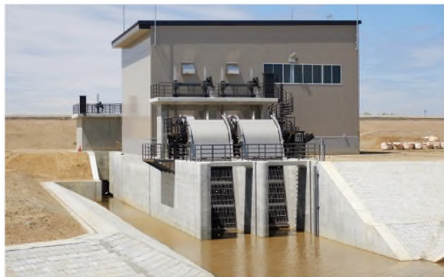
改修した江別太排水機場
