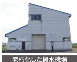
老朽化した揚水機場
