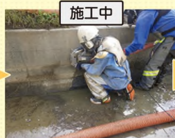
老朽化した表面を除去、清掃した後、 断面修復材で平滑に仕上げる
