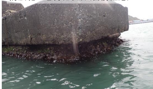
防波堤の老朽化状況(苫前漁港)
