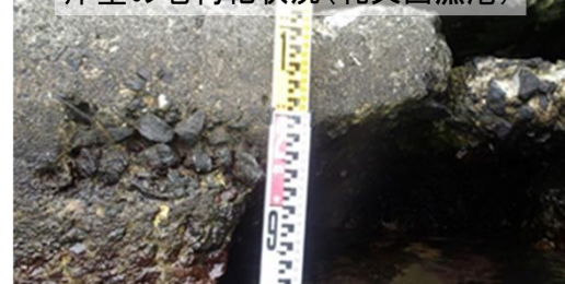
岸壁の老朽化状況(礼文西漁港)
