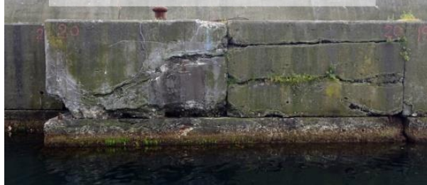
防波堤の老朽化状況(仙法志漁港)
