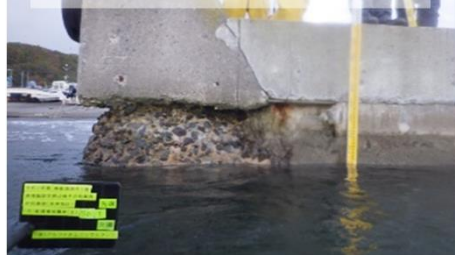
護岸の老朽化状況(余別漁港)
