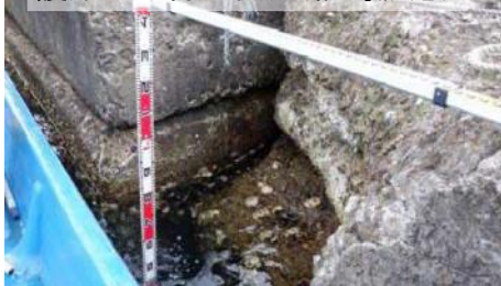
護岸の老朽化状況(福島漁港)
