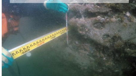
岸壁の老朽化状況(美国漁港)
