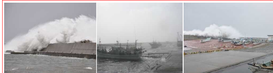
越波により、安全な係留が困難
