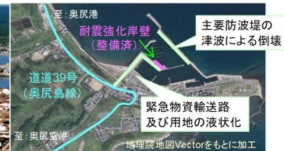
北海道南西沖地震による 青苗漁港の被害
