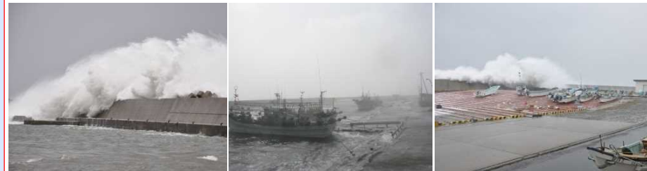
越波により、安全な係留が困難
