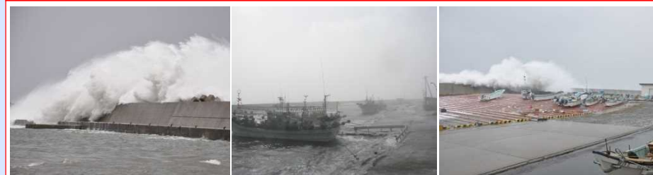
越波により、安全な係留が困難
