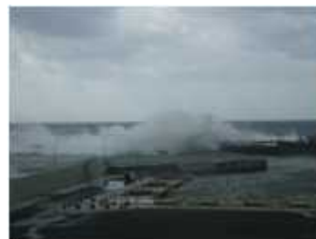
防波堤からの越波状況
