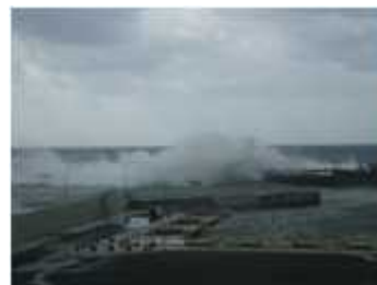
防波堤からの越波状況
