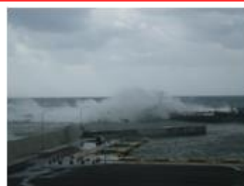
防波堤からの越波状況
