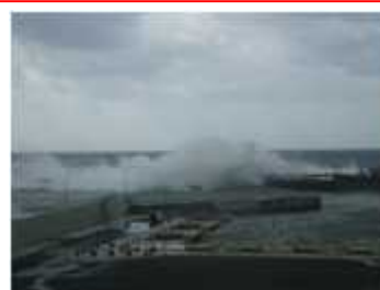
防波堤からの越波状況
