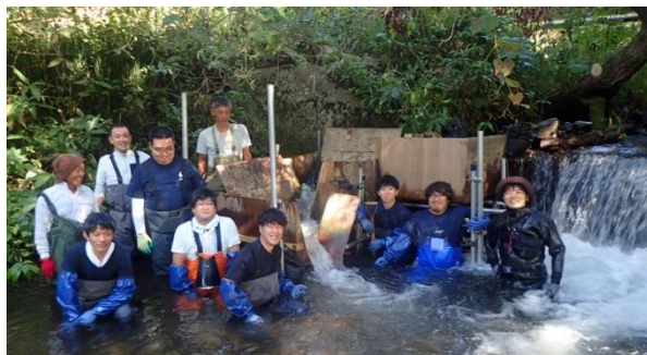
可搬魚道の設置
