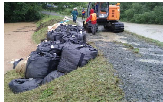
応急復旧工事（KP22.6左岸） （21日10:15における施工中の状況）
