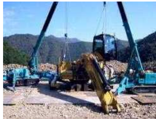
組立作業状況
