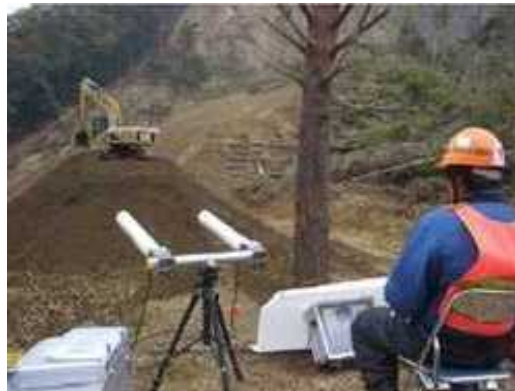
遠隔作業状況
