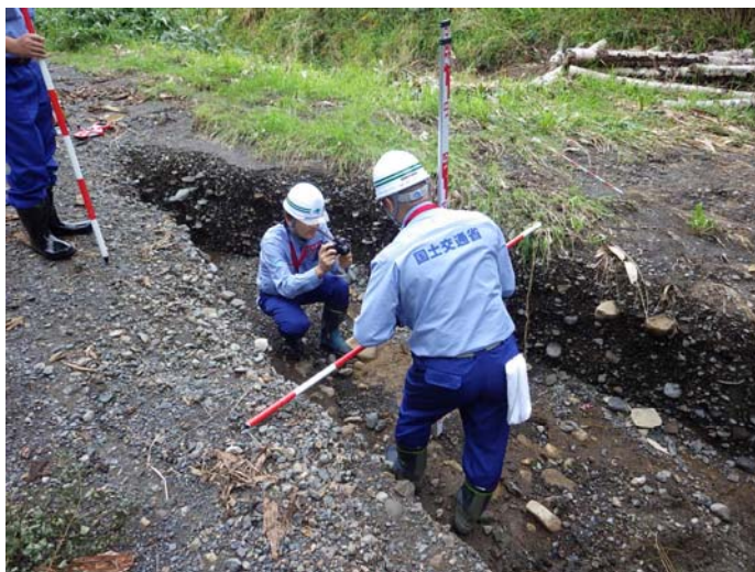
留萌開建道路班 清水町 町道402号被災箇所調査
