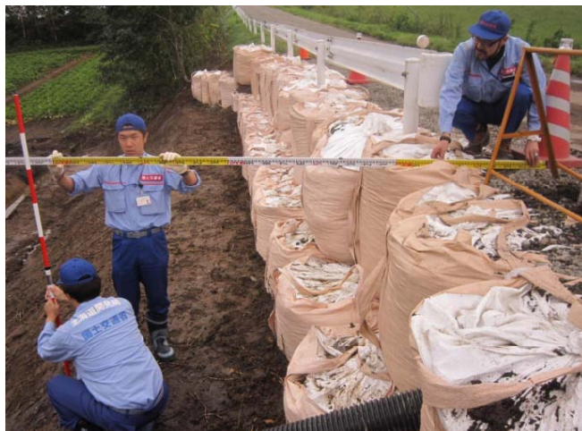
小樽開建道路班 芽室町 町道18号線の仮復旧箇所計測
