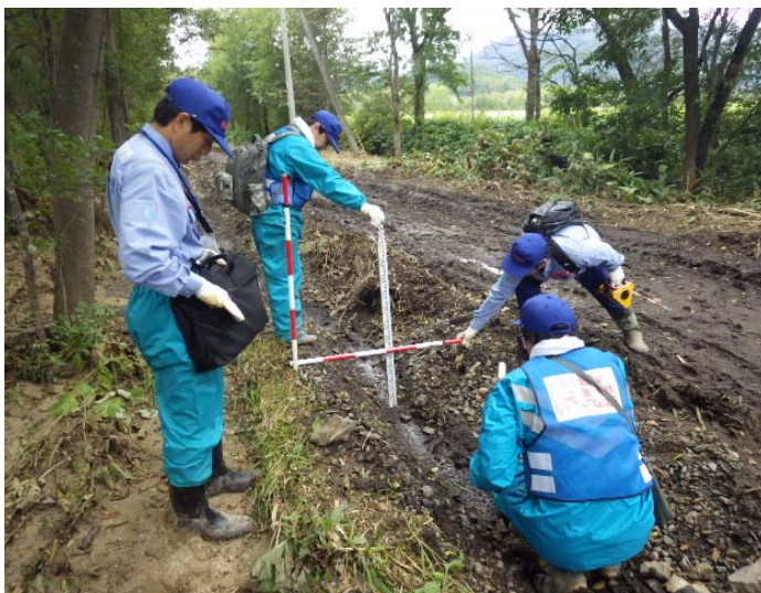
函館開建道路班 清水町 町道旭山10号被災箇所調査
