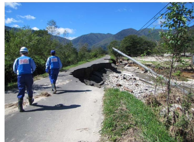
札幌道路班 清水町 羽帯17号道路 被災状況調査
