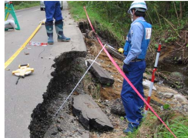
札幌開建道路班 清水町 羽帯16号道路調査状況
