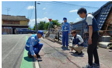
道路の被災状況調査(八代市)
