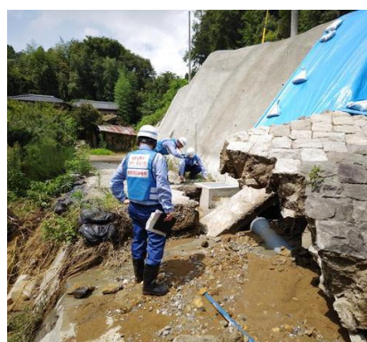
道路法面の被災状況調査 (千葉市)
