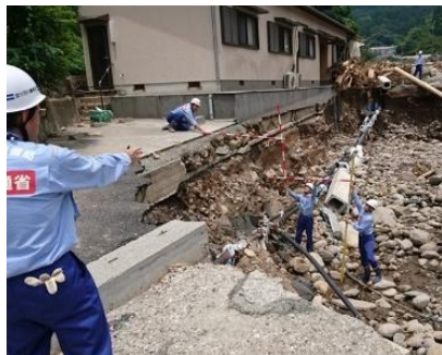
河川被害状況の調査
