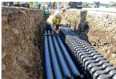
浅層埋設、角型多条電線管の施工 （国道5号 七飯町）
