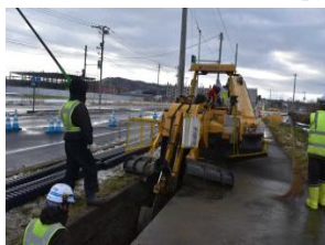
トレンチャー機械による掘削施工 （国道231号 留萌市）
