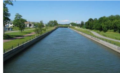
更新整備された用水路
