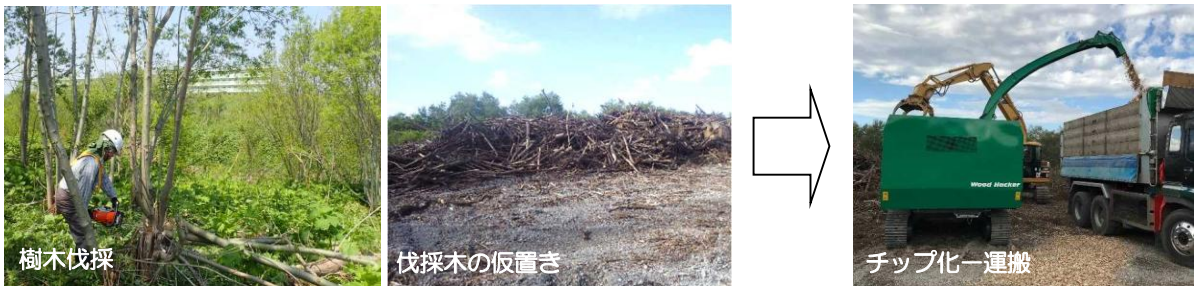
河川内の樹木は、民間での木質バイオマスエネルギー等に利活用
