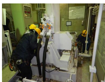
施設の点検（放流設備）
