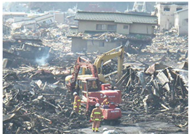
▲道路啓開作業状況
