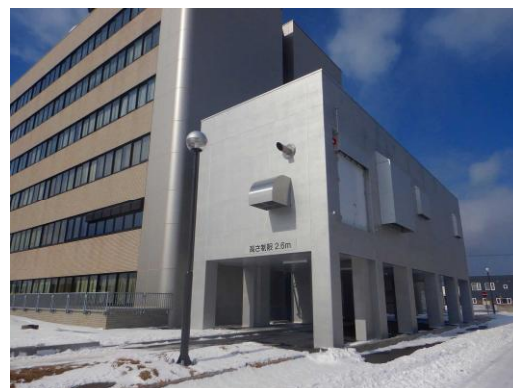
津波浸水対策として、設備棟を増築し、既存庁舎の地下階にある電気室、自家発電室の機能を移設（稚内地方合同庁舎）
