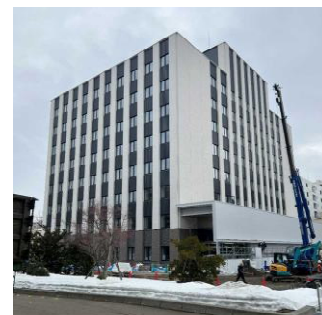
完成した1期棟（東館）
