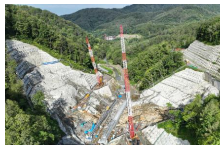
三笠ぽんべつダム（工事状況）
