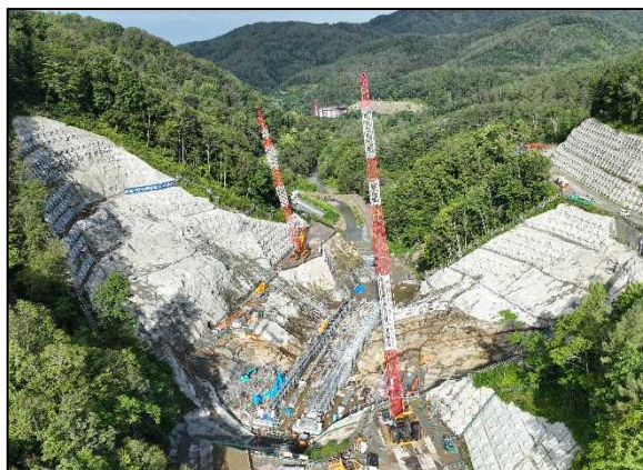
三笠ほんべつダム（工事状況）
