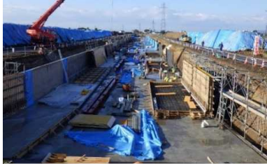
用水路の改修工事
