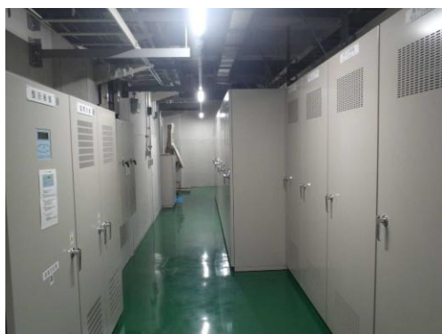
庁舎受変電設備の改修（電力確保）
