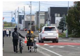
可搬式ハンプ設置状況 (富良野市)
