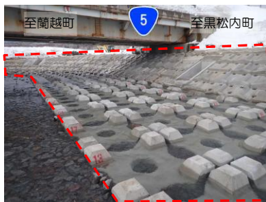
国道5号 蘭越町（対策事例）
