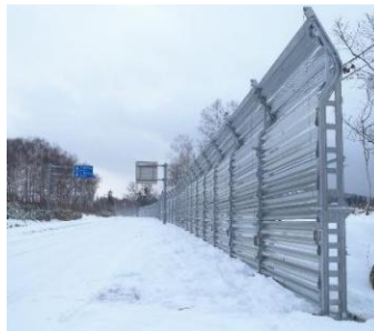
防雪柵の整備
