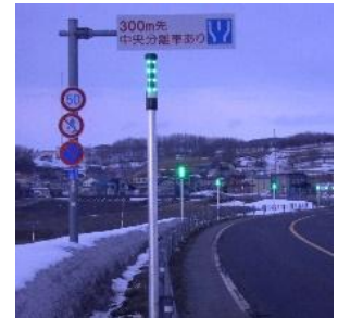
自発光式の視線誘導標の整備
