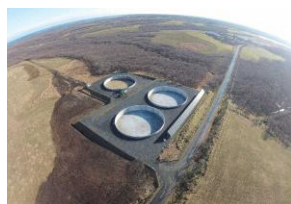
肥培施設の整備 (配水調整池)
