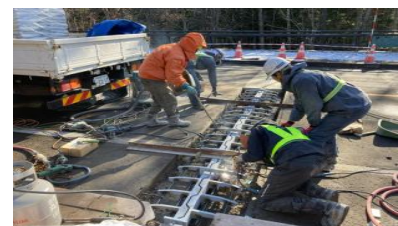
伸縮装置補修
