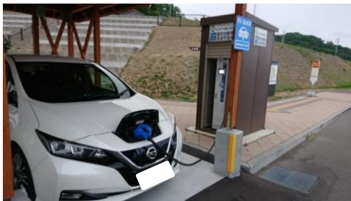
道の駅「石狩あいりーど厚田」での充電状況
