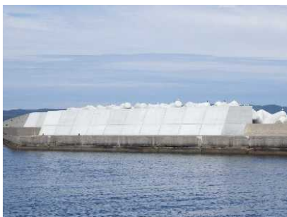
対策事例（防波堤の高上げ）
