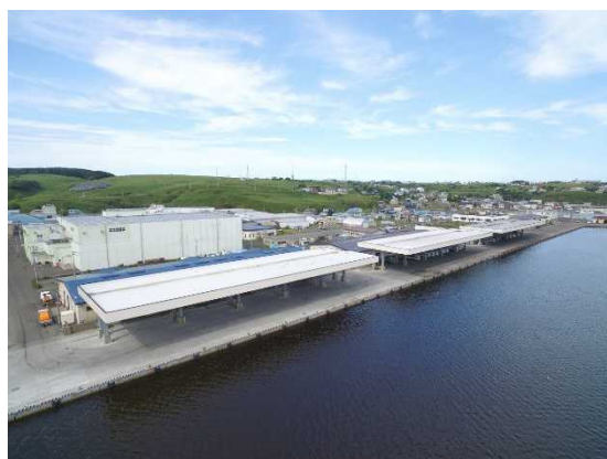
根室港 屋根付き岸壁 （令和7年9月供用）
