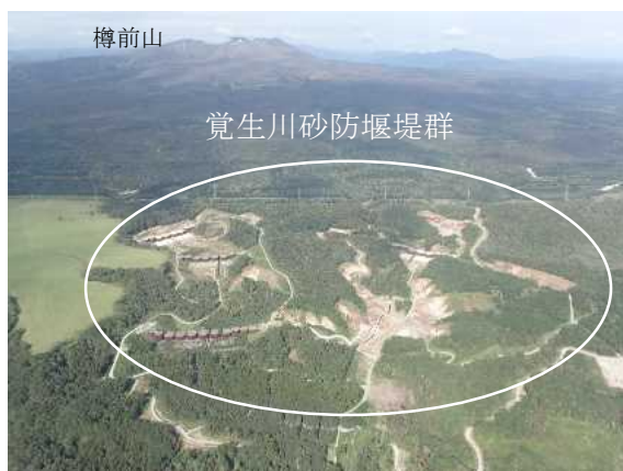
覚生川砂防堰堤群(建設中)
