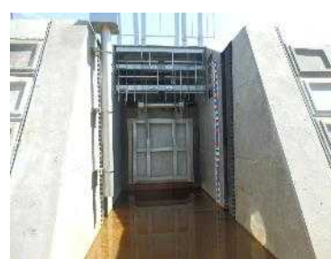
施設の補修に合わせた 自動開閉式ゲートの導入事例
