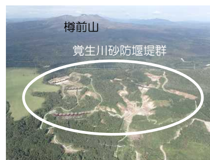
樽前山 覚生川砂防堰堤群 おぼっぴ 樽前山覚生川砂防堰堤群の整備
