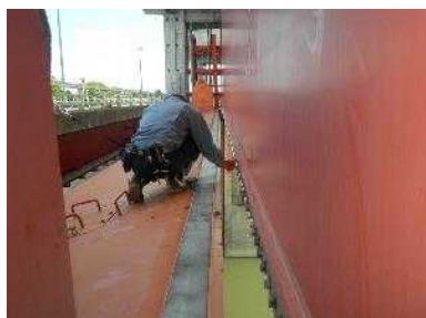
施設の点検（水門ゲート設備）
