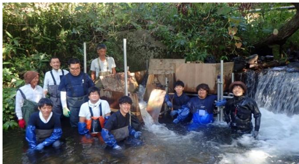
可搬魚道の設置
