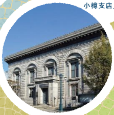
重要文化財 「旧三井銀行 小樽支店」
