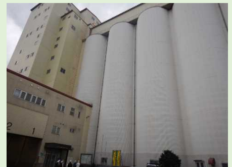
三ツ輪運輸飼料原料貯蔵施設
