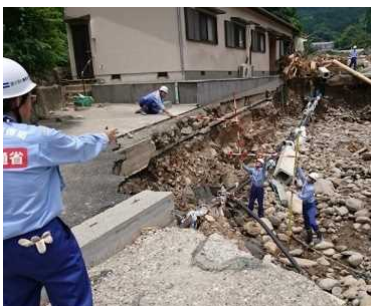
河川被害状況の調査
