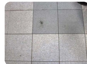
整備後の舗装面
