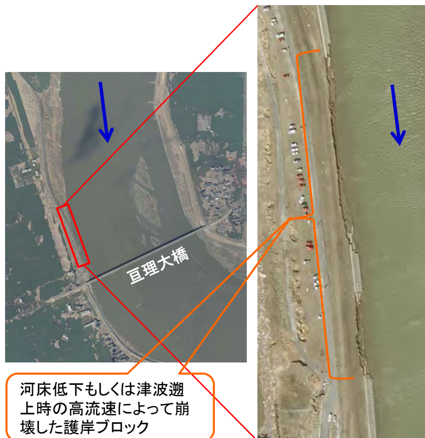
津波遡上に伴う護岸の崩壊(阿武隈川)
