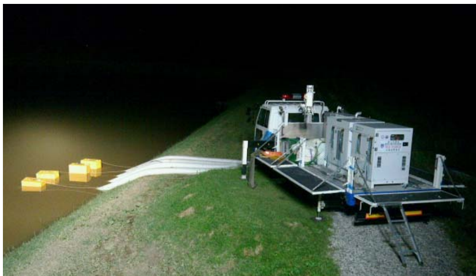
排水ポンプ車による湛水排除作業(栗原市)
