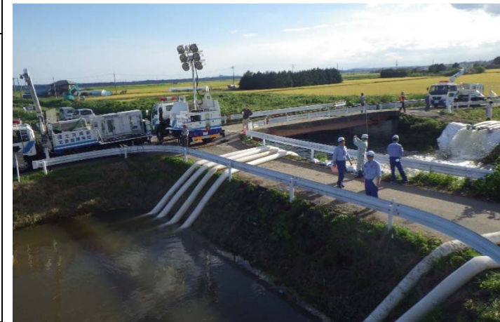
宮城県美里町定川水系青木川で作業を開始
