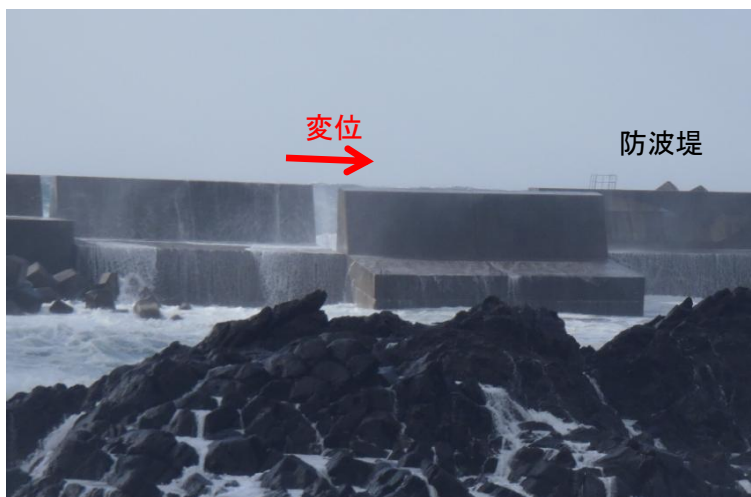
高波により、変位した防波堤 (写真上下いずれも 久遠郡せたな町・須築(すつき)漁港)
