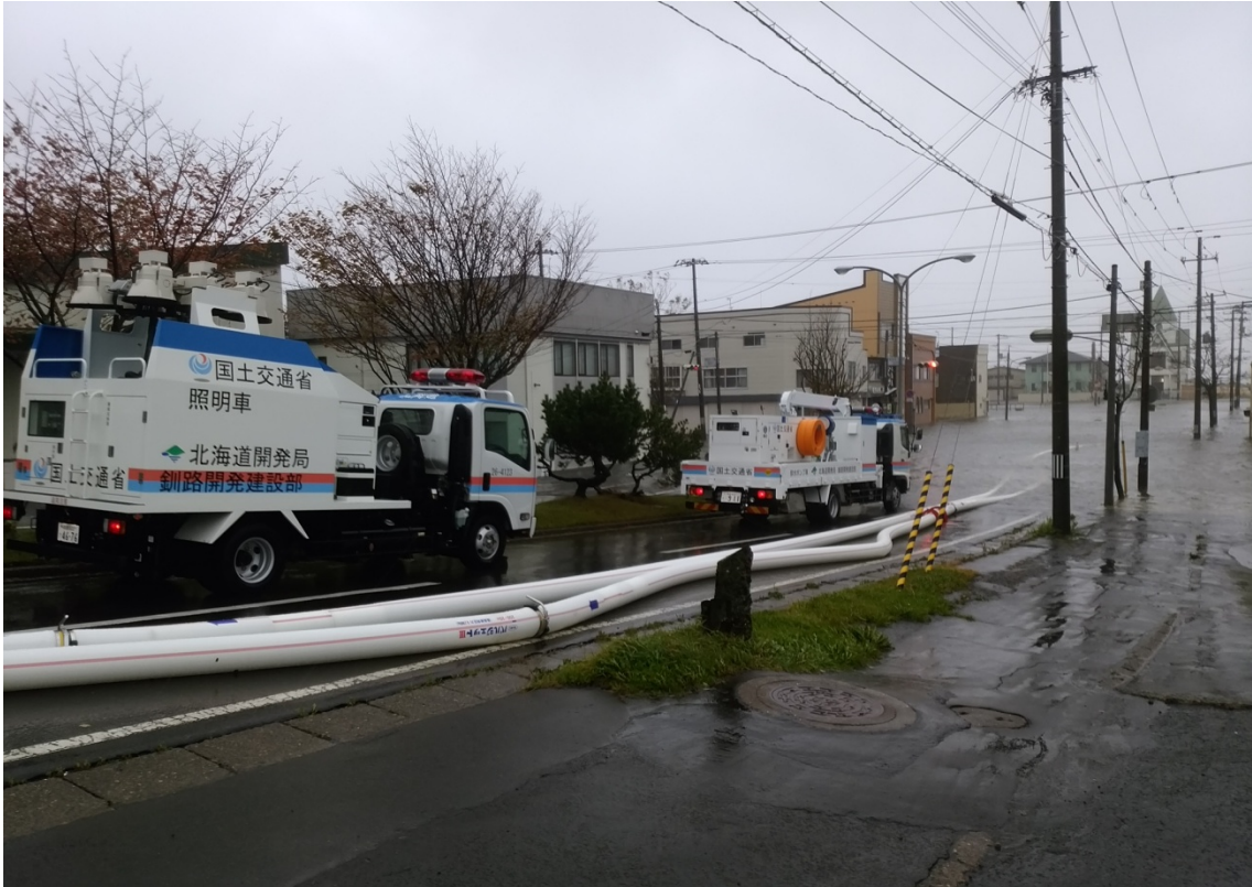
根室市内弥生町1丁目交差点に派遣した排水ポンプ車による排水状況 ※夜間作業に備え、照明車も待機
