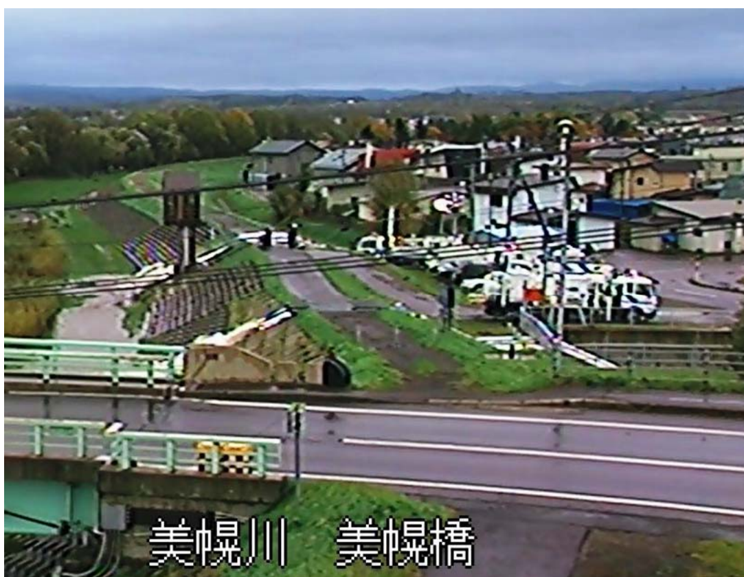
排水ポンプ車による内水排除状況
