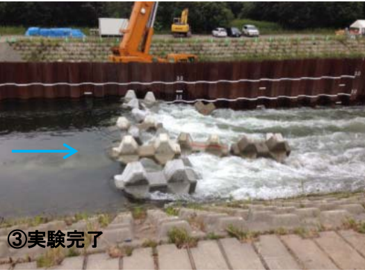
資材（消波ブロック） の投入に使用した 建設機械
