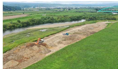
氾濫をできるだけ防ぐ河道掘削
