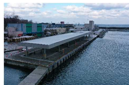
屋根付き岸壁（増毛港）
