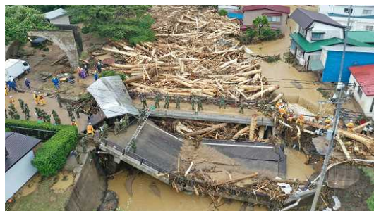
流木による橋梁箇所の閉塞被害 (青森県小赤川)
