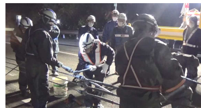
ワイヤロープ式防護柵の撤去状況（訓練）
