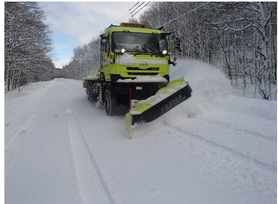
国道391号 野上峠 除雪状況 (1/12 9時)
