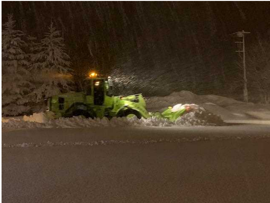
国道236号 野塚峠 除雪状況 (1/11 21時)
