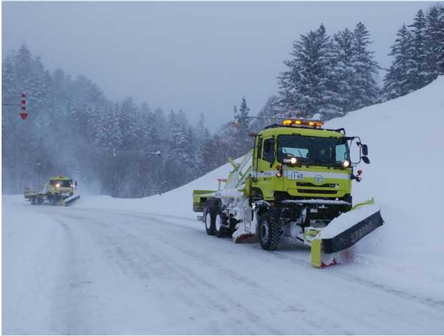
国道39号 石北峠 除雪作業状況 (1/13)
