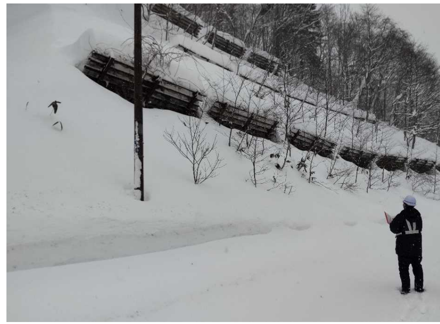
国道453号 千歳市幌美内 道路点検状況 (1/13)
