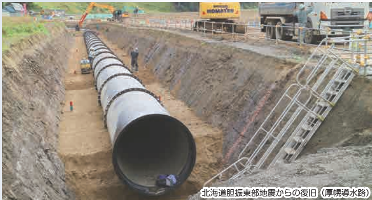
北海道胆振東部地震からの復旧 (厚幌導水路)
