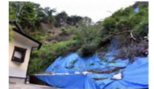
豪雨の度に土砂崩れが多発
