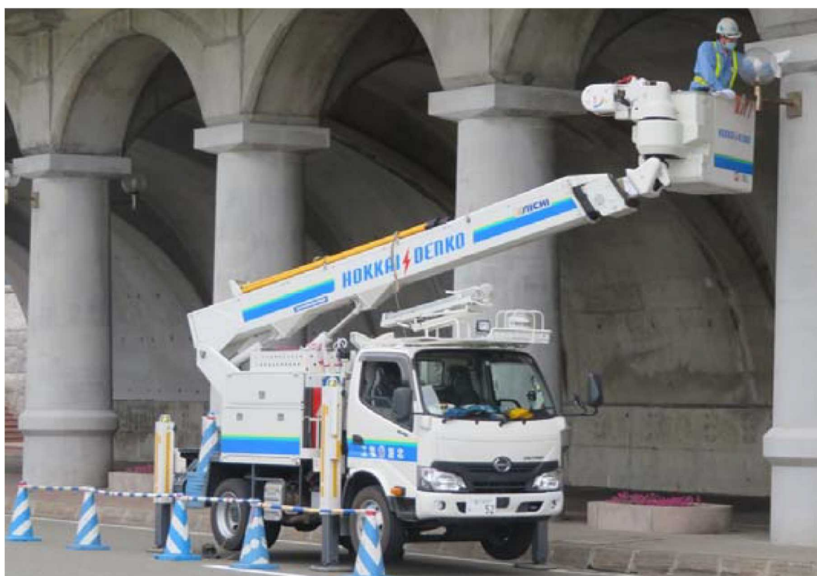
北海電気工事(株) 稚内営業所の活動状況 (稚内港北防波堤ドーム内の照明清掃)
