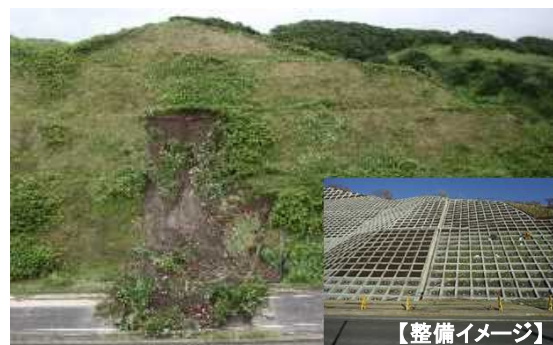
〈道路インフラの局所的な防災・減災対策等(法面对策)〉
