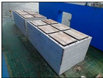
対策例(防波堤延伸のためのケーソン製作)
