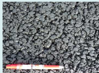
過去に試験道路で 実施した路面状況
