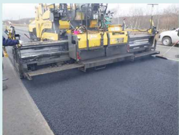
過去に試験道路で 実施した施工状況
